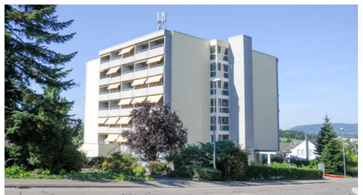
NUN ERSTRAHLT DAS HAUPTGEBÄUDE WIEDER IM NEUEN GLANZ
