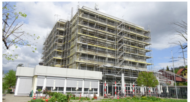
DAS HAUS A WAR WÄHREND 3 MONATEN VOLL EINGERÜSTET
